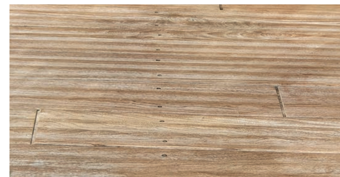
Πολυκαιρισμένη βεράντα από Thermo-Ash μετά την επεξεργασία με το DeckDegrayer.
