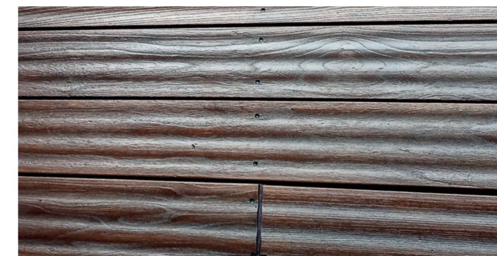
Ανακαινισμένη βεράντα από Thermo-Ash μετά το φινιρίσμα με DeckFinish Color Σκούρο καφέ
